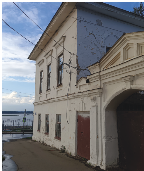
Здание Чистопольской Общественной и купца Полякова Богадельни. Чистополь, 2024 г. Из личного архива автора.
