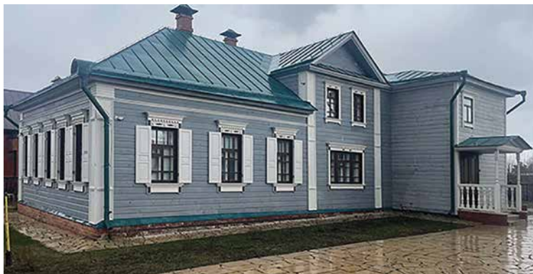
Здание Ольгинского детского приюта трудолюбия в селе Свияжск, после реставрации. Апрель 2024 г.
