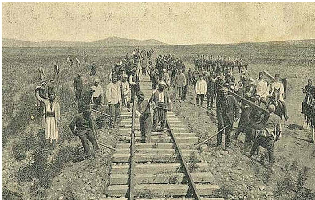
Строительство Хиджазской железной дороги.
